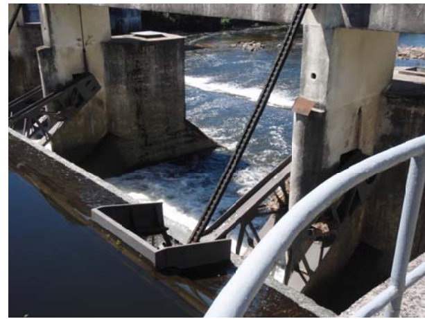
Photos n° 10 & 11 : Vanne segment - détail des parties mobiles et piles du barrage
