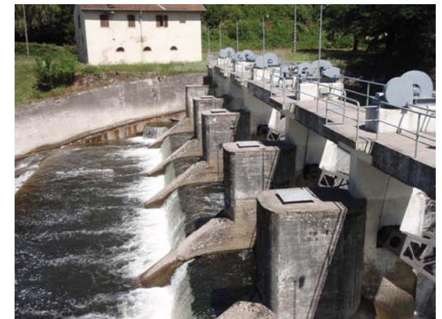
Photos n° 18 & 19 : de gauche à droite, radier aval, poutre cintrée, piles du barrage et passerelle
