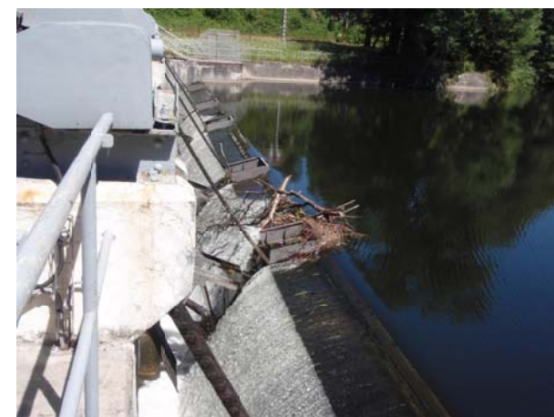
Photo n° 9 : Treuil et vannes segment
