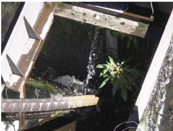
Photos n° 16 & 17 : Vanne segment - intérieur des panneaux dégradé
