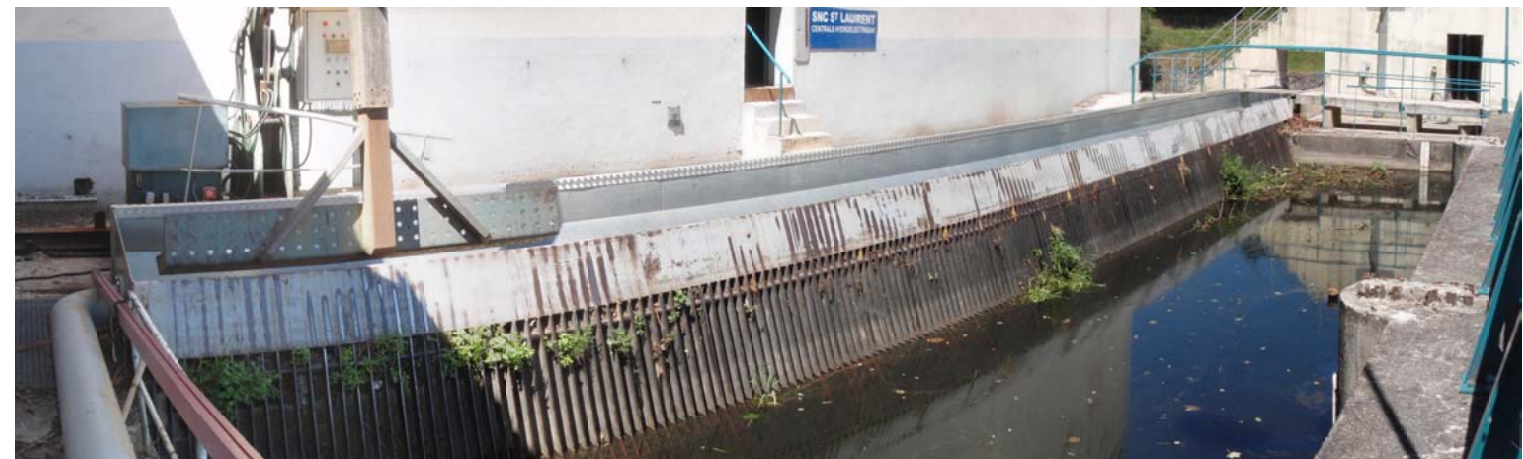
Photo n° 6 : Plan de grille du barrage, rive gauche
