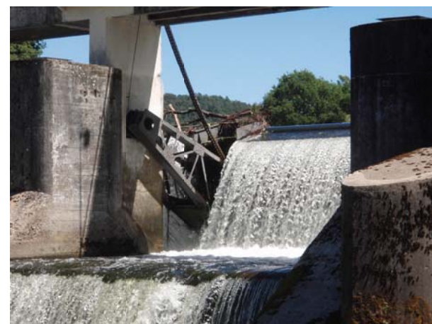
Photo n° 8 : Vanne segment et piles du barrage
