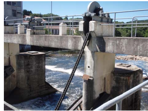
Photos n° 12 & 13 : Treuils de manoeuvre des vannes
