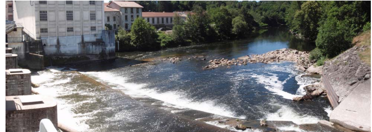
Photo n° 4 : Aval du barrage, radier aval et atterrissement
