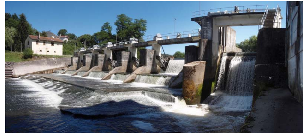
Photo n° 2 : Barrage Hartmann, vu de la rive gauche aval
