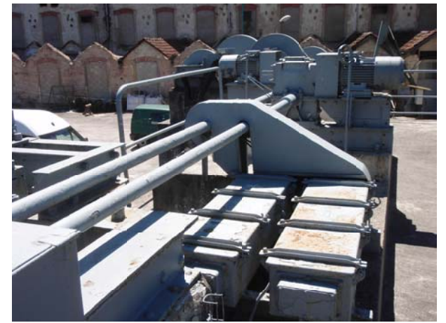
Photos n° 12 & 13 : Treuils de manoeuvre des vannes
