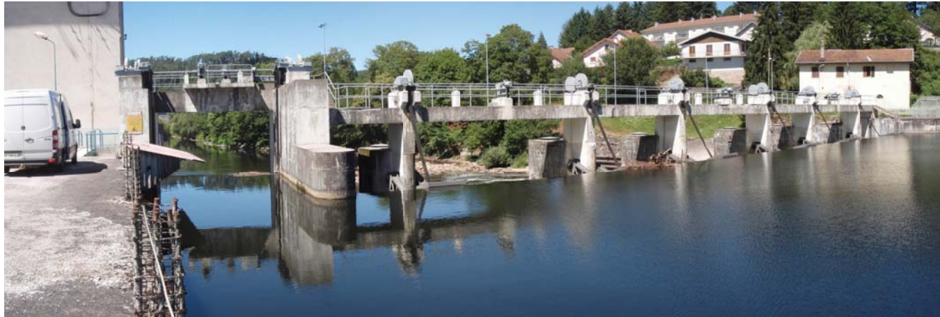
Photo n° 3 : de gauche à droite, vanne de chasse, vannes segment et passe à poisson
