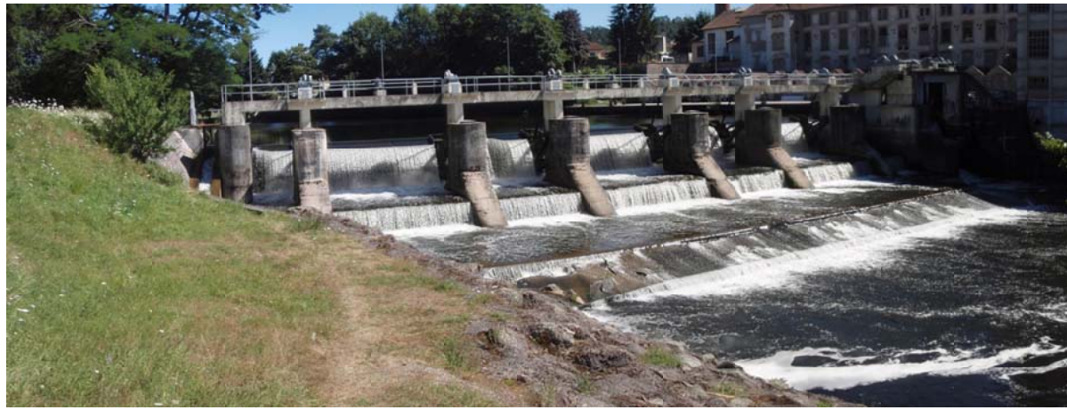
Photo n° 1 : Barrage Hartmann, vu de la rive droite aval
