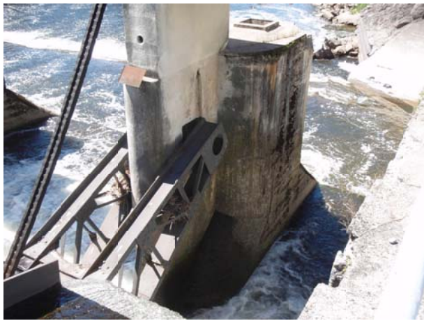
Photos n° 10 & 11 : Vanne segment - détail des parties mobiles et piles du barrage
