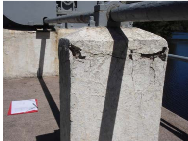
Photo n° 13 : Piles du barrage, état dégradé
