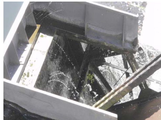
Photos n° 16 & 17 : Vanne segment - intérieur des panneaux dégradé
