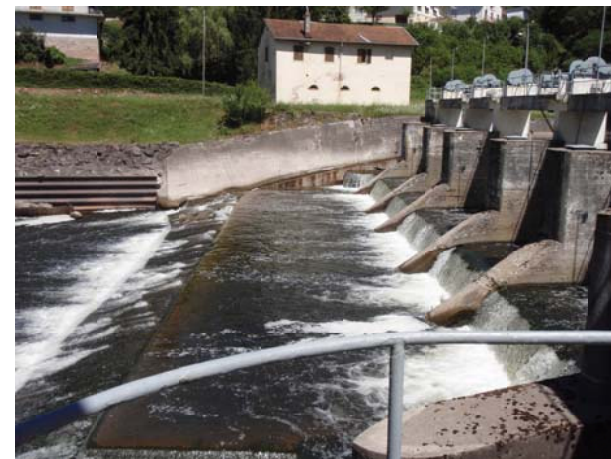
Photos n° 18 & 19 : de gauche à droite, radier aval, poutre cintrée, piles du barrage et passerelle
