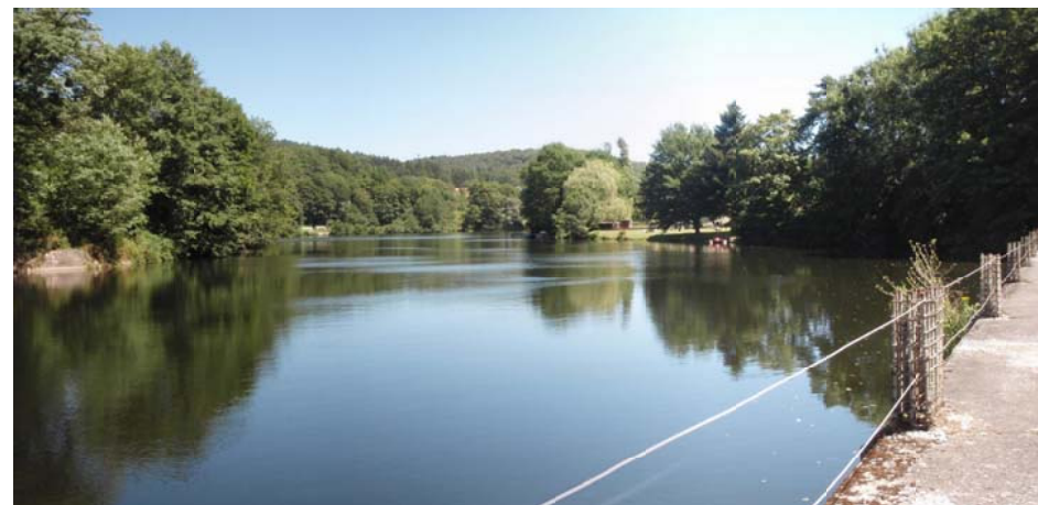
Photo n° 5 : Retenue en amont de l'ouvrage
