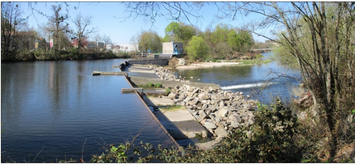
Photo n°6 : Barrage de la Gosse
