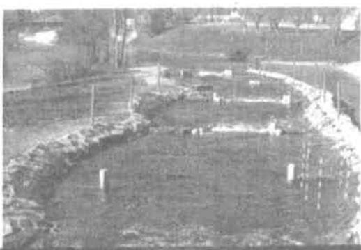
*L'alimentation en eau du parcours d'eau vive se fait par l'intermédiaire d'une vanne toit qui permet de réguler le débit directement à l'amont. Parallèlement à cette vanne toit, une passe à poissons de type « passe à bassins successifs » a été installée afin que les poissons migrateurs puissent remonter la rivière sans difficulté.*
