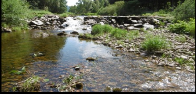
Rétablissement de la continuité écologique par effacement d'ouvrage sur la Moselotte à Vagney
